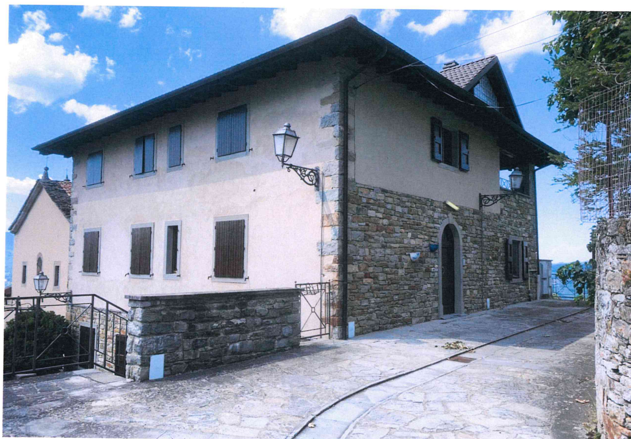
Esterno - lato est - accesso carrabile
