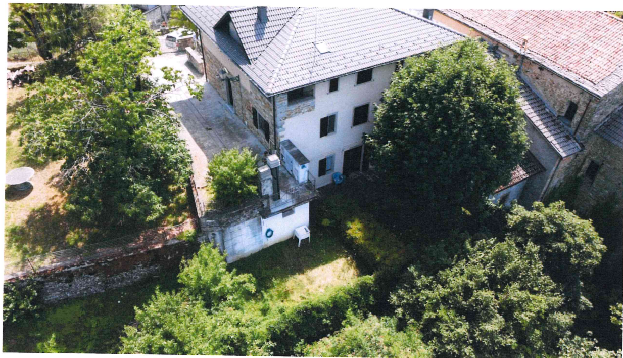
Esterno - lato nord
