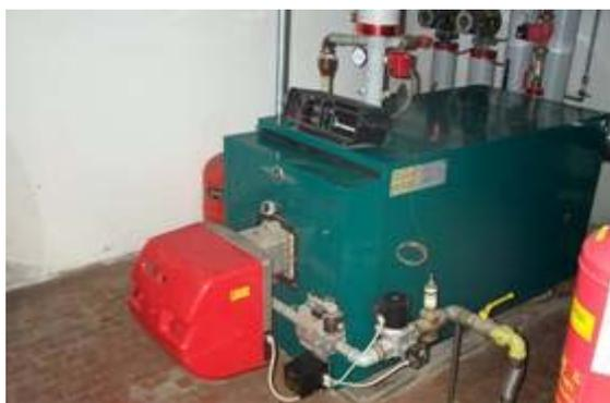
La caldaia a metano di 176 kW di potenza reale, installata nel settembre del 2003.
