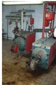
Le caldaie a gasolio del municipio (116 kW).
